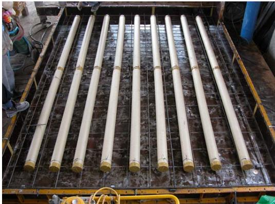
사진 2. 하부철근 및 중공관(지관) 설치
