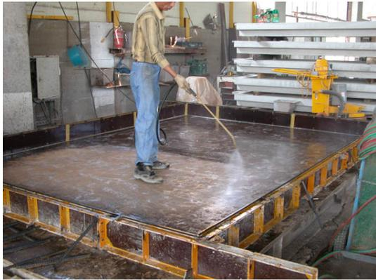
사진 1. 거푸집 설치 및 청소
